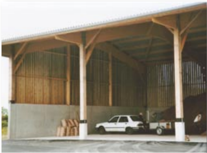
Un exemple de plateforme de stockage de bois énergie
